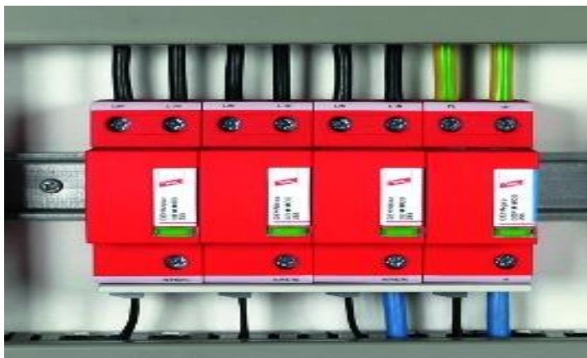
Рис.5.13 модульная защита от импульсных перенапряжений
