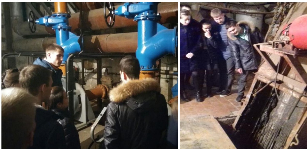
Рис. 1. Экскурсия студентов направления «Природообустройство и водопользование» на канализационную насосную станцию
