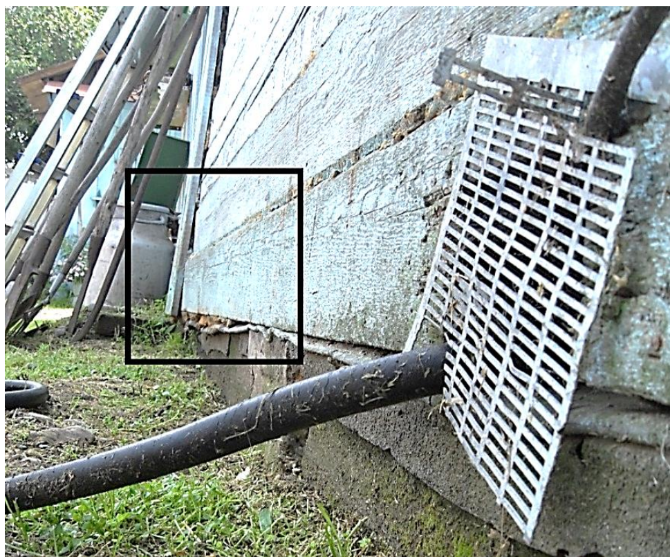
Рис. 5. Стена, идущая вдоль оси Б, отошла преимущественно в пределах двух своих нижних венцов от стены, идущей вдоль оси 2, на величину до 40 мм
