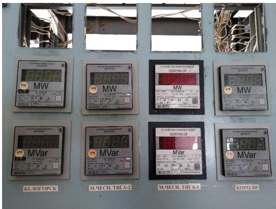
Рис. 6. Цифровые приборы измерения активной и реактивной мощности на отходящих линиях Белогорск, М.Чесноки тяга – 2, М.Чесноки тяга – 1, Короли
