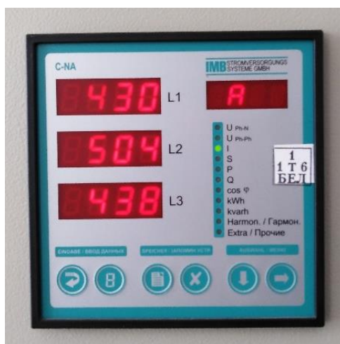
Рис. 7. Мульти – прибор компании «IMB» для постоянного одновременного измерения U, I, S, P, Q, cosφ, kWh, kvarh, гармоника на фазах А, В, С (L1, L2, L3)
