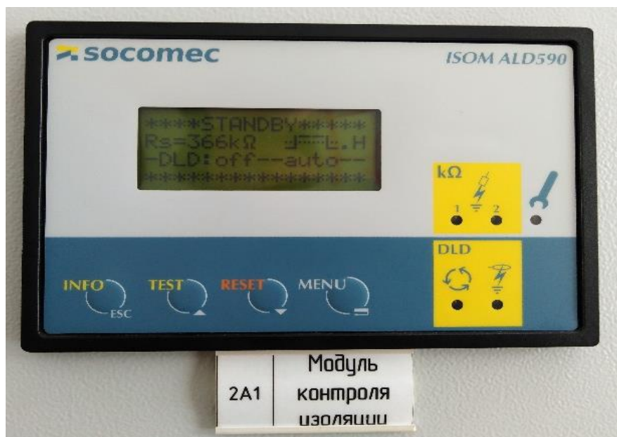
Рис. 11. Модуль контроля изоляции компании «Socomec» с выведенным параметром «сопротивление линии»
