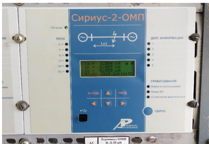
Рис. 12. Терминал компании «Сириус» для определения места повреждения (ОМП) В-Л-35 кВ Ледяная с выведенными параметрами тока на фазах А, В, С
