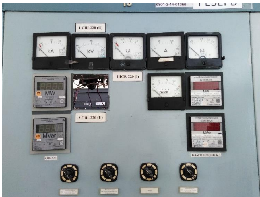
Рис. 5. Частичная замена стрелочных – аналоговых приборов на цифровые
