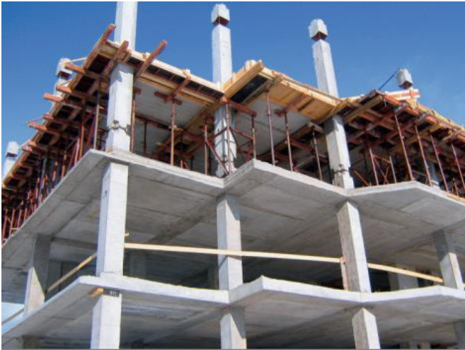
Рис. 1. Сборно-монолитный каркас здания
