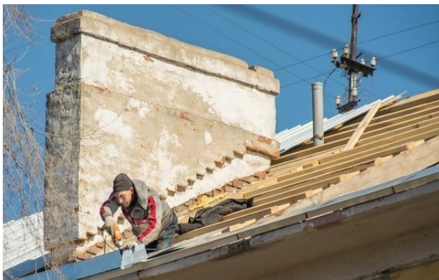
Рис. 3. Ремонт скатной крыши
