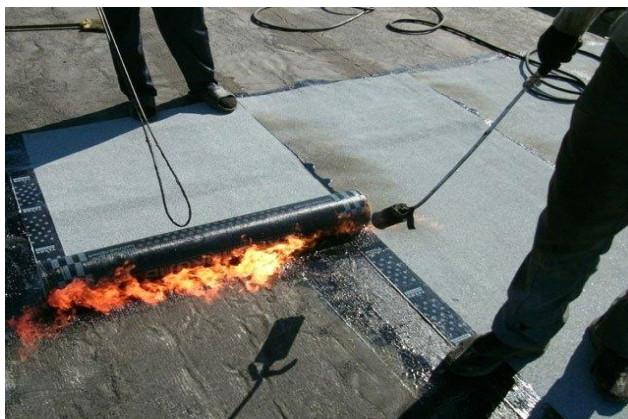
Рис. 2. Ремонт плоской крыши с применением специальной газовой горелки
