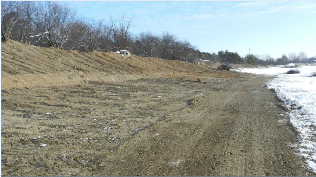
Фото 2. Участок уположенного берегового откоса до проектных значений
