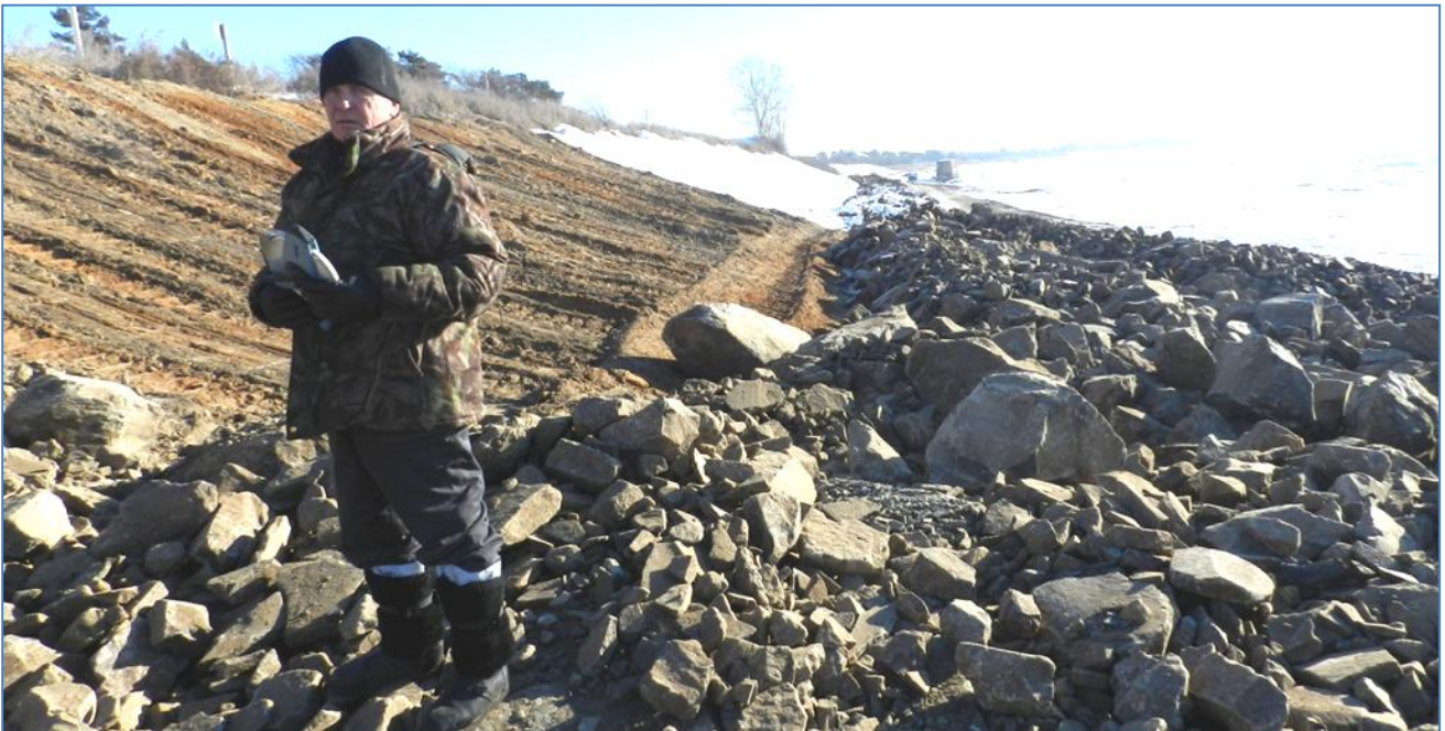
Фото 1. Карьерный камень, используемый для упорной призмы
