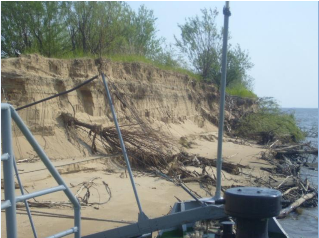
Рис.1. Разрушение берега р. Амур в результате бокового подмыва (фото автора)
