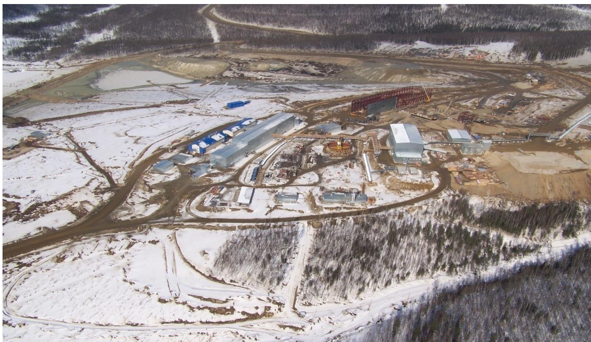
Рис. 10.2. Строительство ГОК Маломир Селемджинский район
