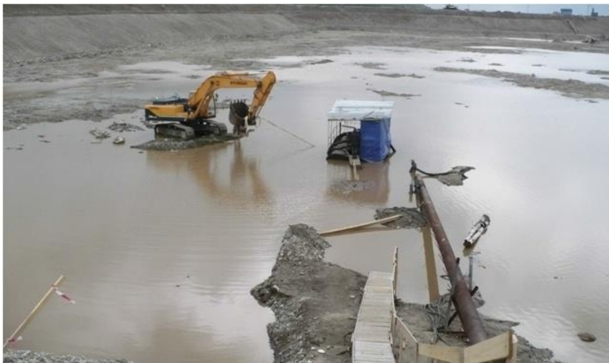
Рис. 10.1. Строительство Бурейской ГЭС (начальный период)
