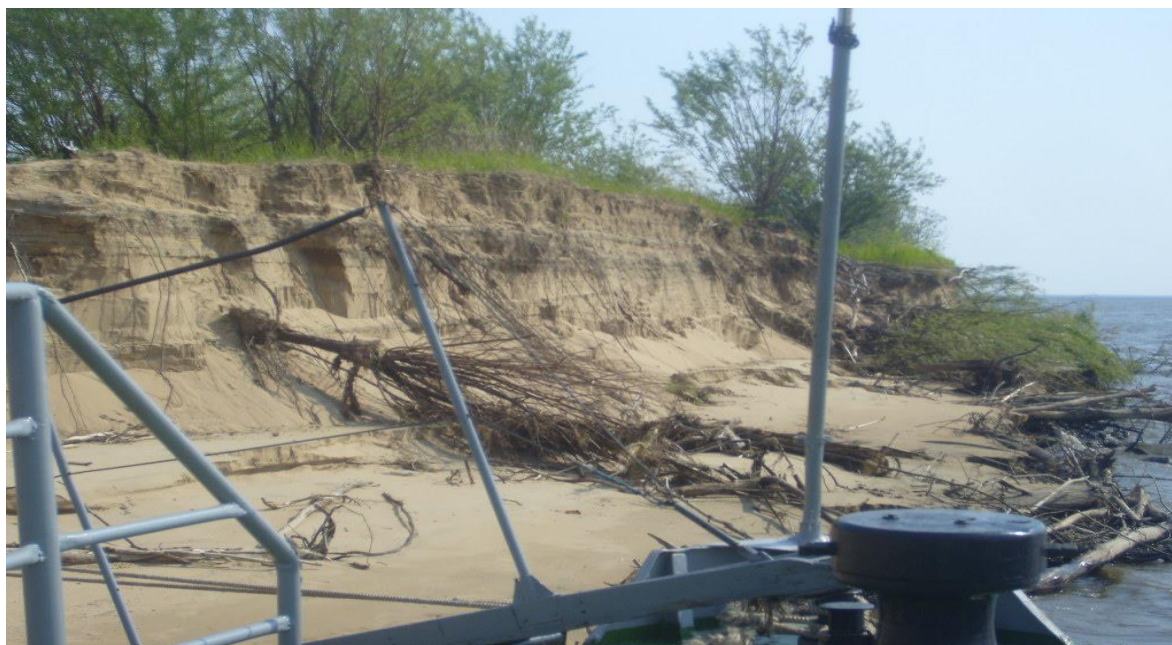
Рис. 1.5. Разрушение берега реки в результате подмыва рыхлых отложений
