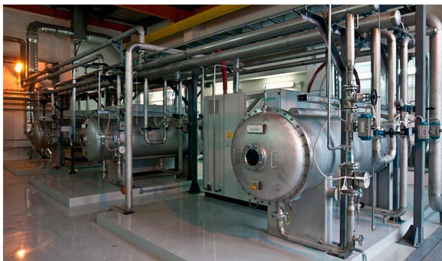
Рис. 2. Озонаторная на блоке К-6
