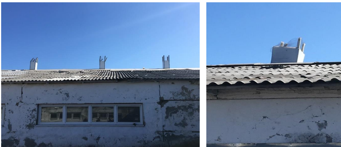
Рис. 2. Последствия обледенения вентиляционных шахт на коровниках Амурской области
