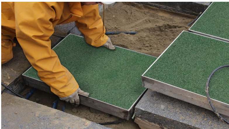
Рис. 1. Плита со встроенными пьезогенераторами фирмы «Pavegen»
