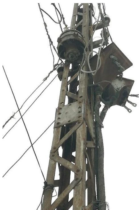
Рис. 1. Фрагмент металлической многоэлементной опоры ЛЭП
