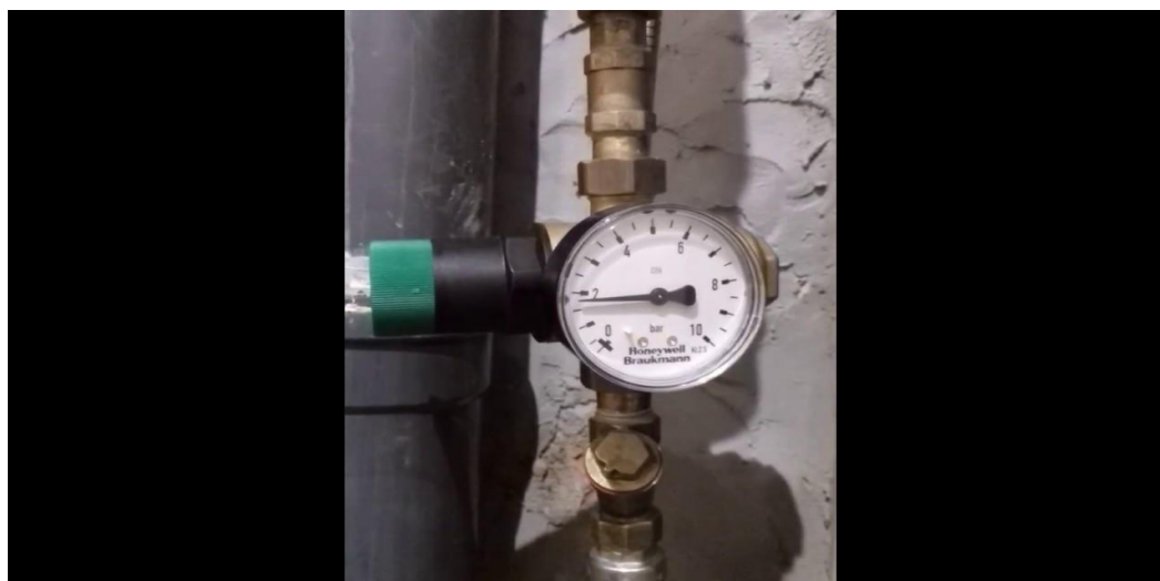
Рис. 1. Редуктор давления (поршневой)
