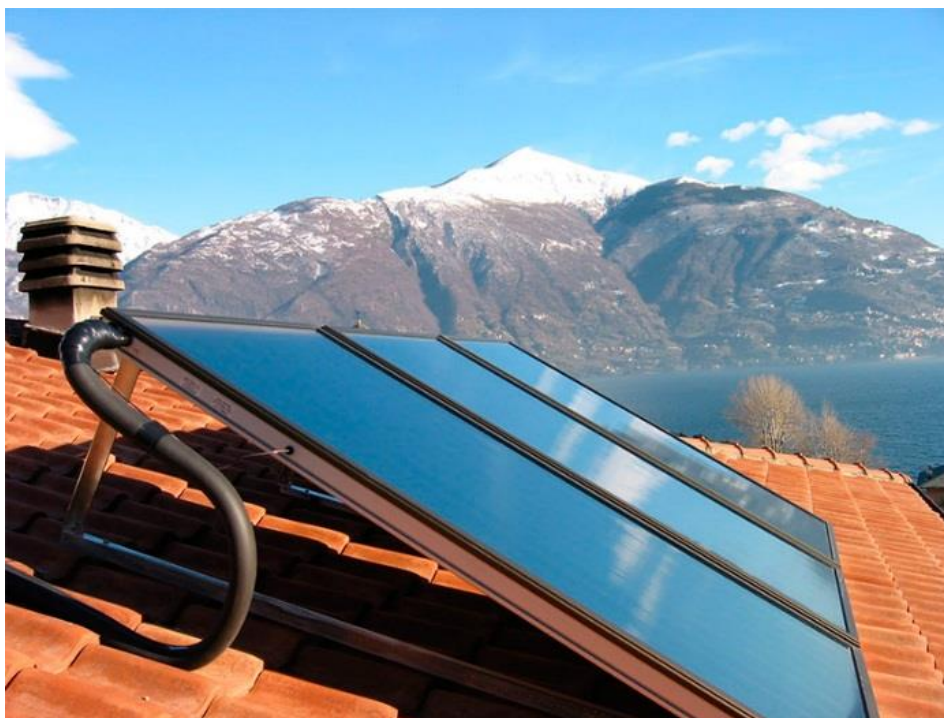
Рис. 2. Плоский солнечный коллектор
