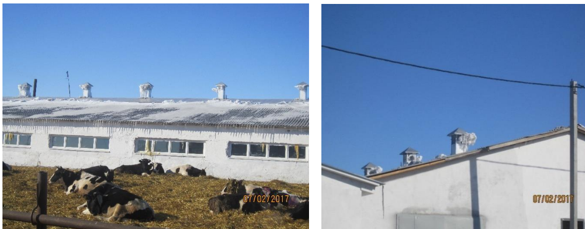
Рис. 1. Обледенение вентиляционных шахт в Амурской области
