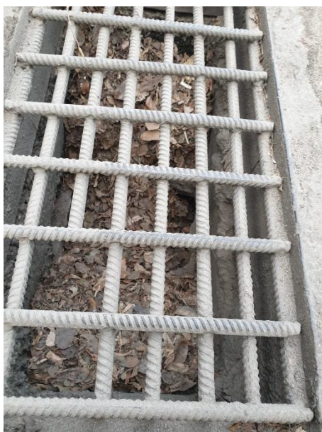
Рис. 3. Дождеприемный колодец, расположенный на ул. Кантемирова
