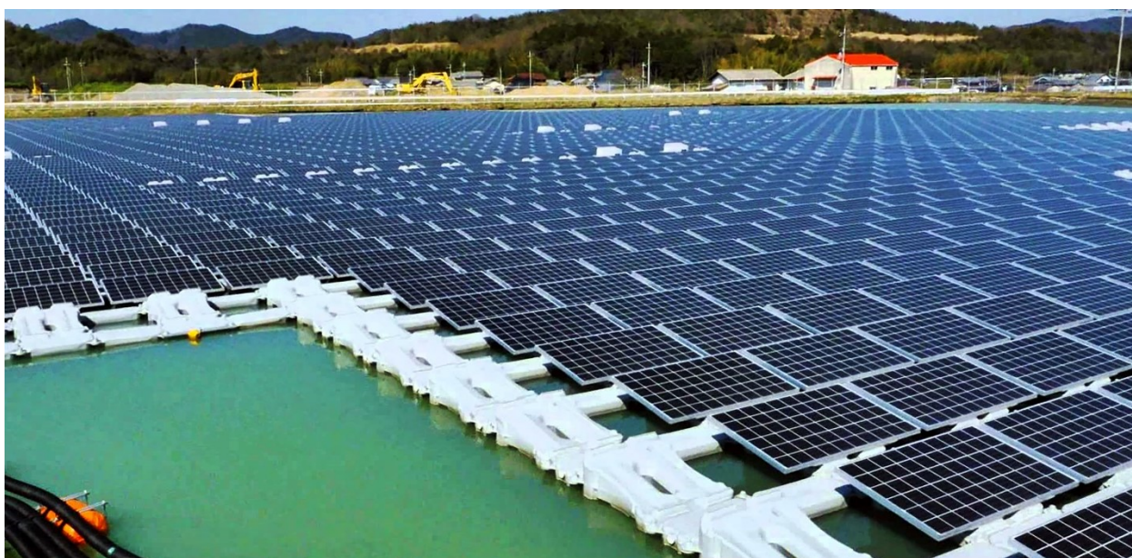
Рисунок 1 – Вид плавучей солнечной электростанции
