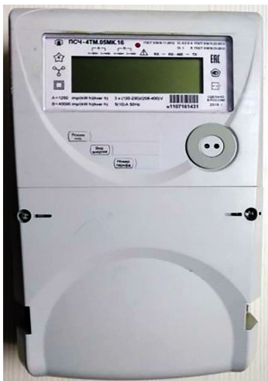
Рисунок 2 – Двунаправленный счетчик
