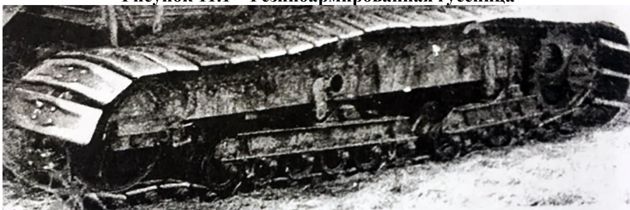
Рисунок 11.2 – Металлическая ходовая часть
