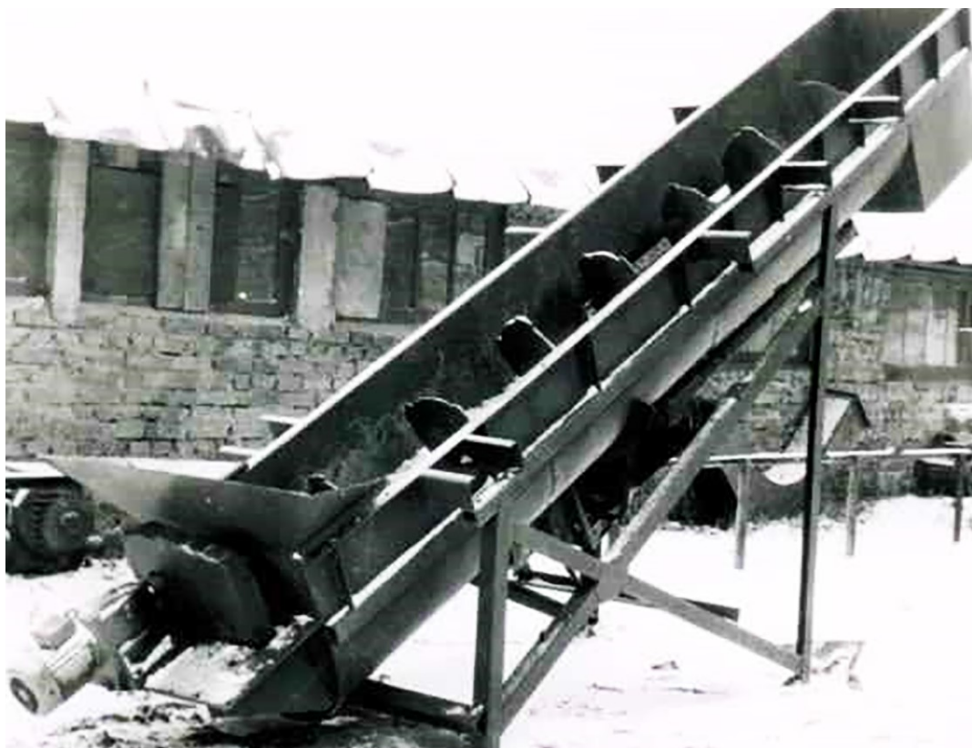
Рисунок 3.7 – Общий вид смесителя-усреднителя
