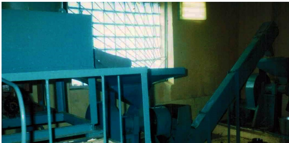
Рисунок 4.12 – Общий вид оборудования цеха по производству белково-минерального (соево-ламинариевого) гранулята
