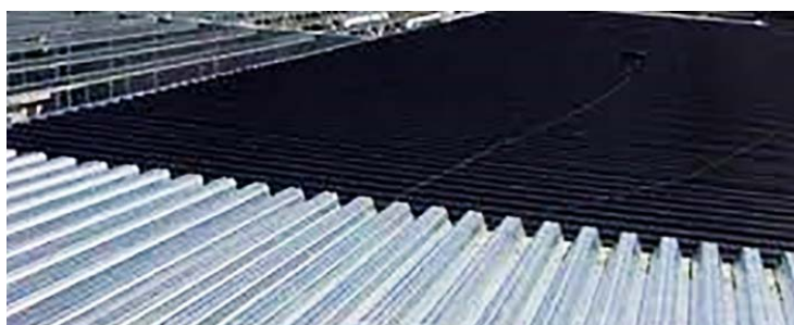
Рисунок 3 – Кровля из профнастила
