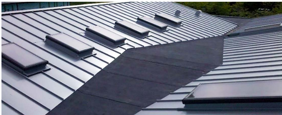
Рисунок 2 – Кровля из металлочерепицы
