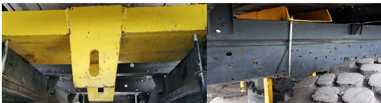
Рисунок 3.9 – Установка опорного рычага на раме автомобиля
