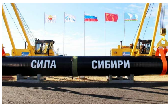
Газопровод «Сила Сибири»
