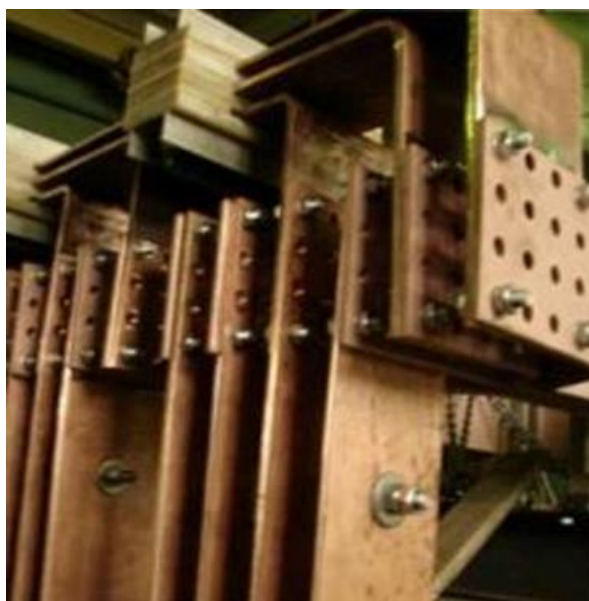
Рис 3.2 - Конструкция неподвижных (жестких) неразмыкаемых контактных
