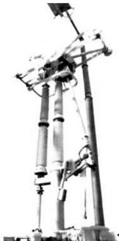
Рис. 4.5. Разъединитель пантографического типа
