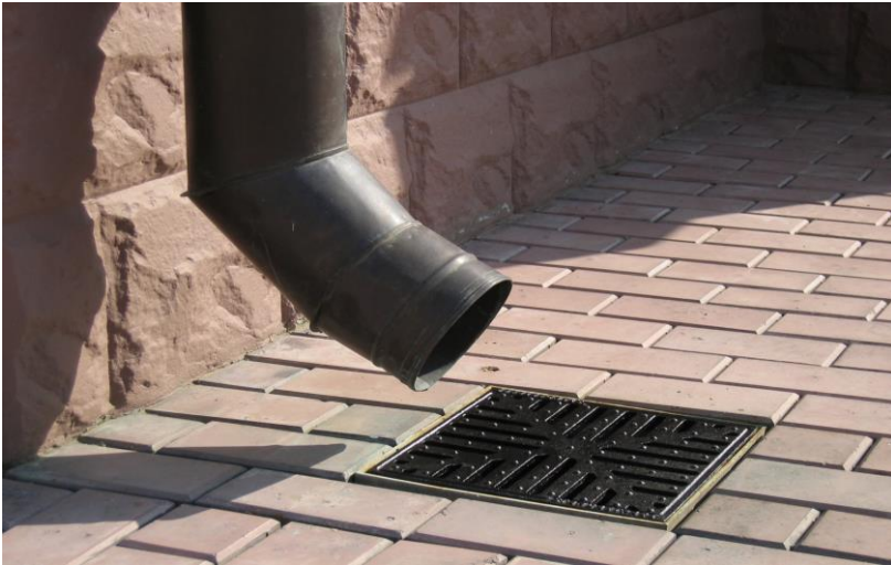
Рис. 1.16. Устройство ливневой канализации
