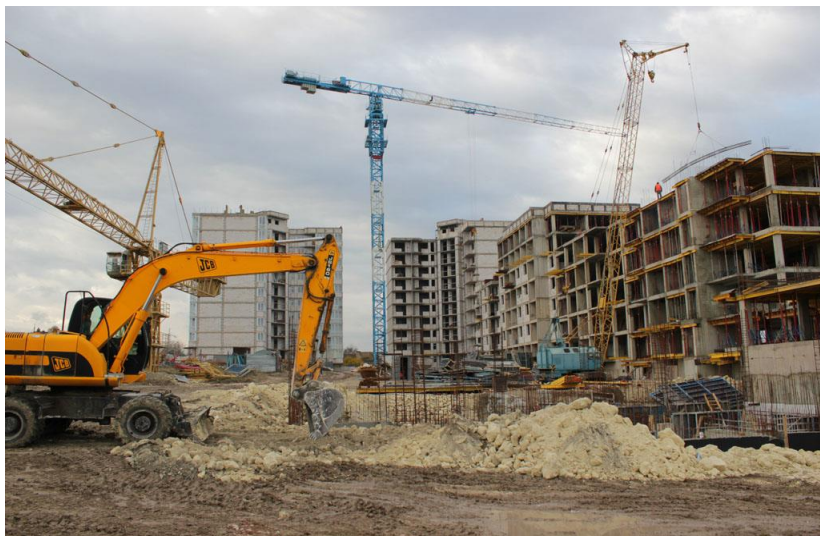
Рис. 1.13. Подготовка к прокладке трубопроводов на строительной площадке
