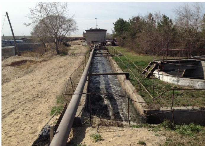
Рис. 1.9. Подача городских сточных вод на отстойники
