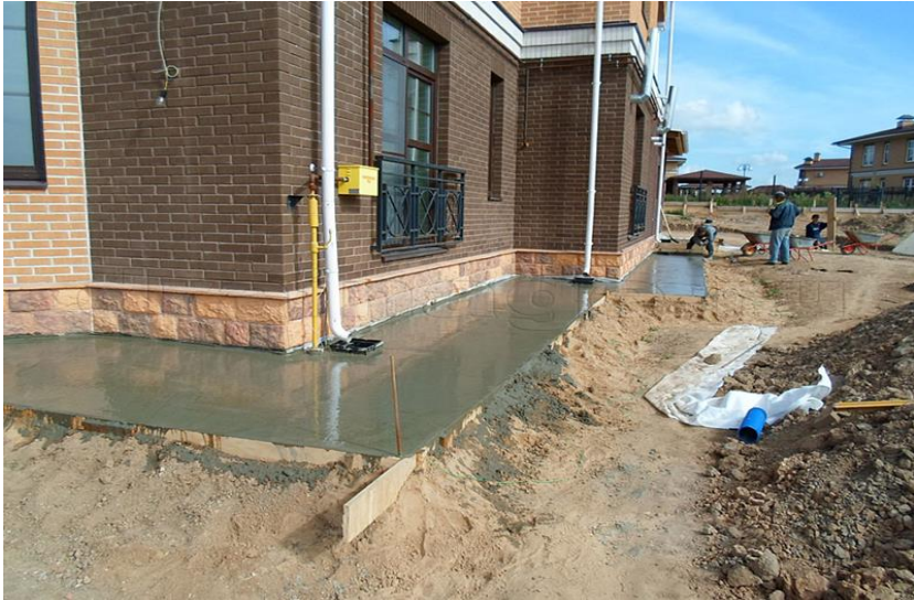
Рис. 1.14. Подготовка к прокладке трубопроводов ливневой канализации
