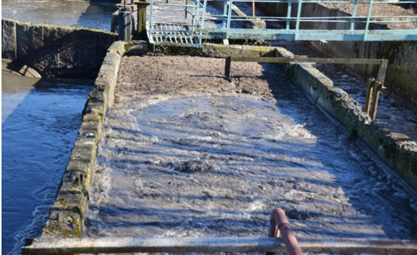
Рис. 1.11. Аэротенки, заселяются бактериями, которые «поедают» ненужное и дают на выходе чистую воду и ил.
