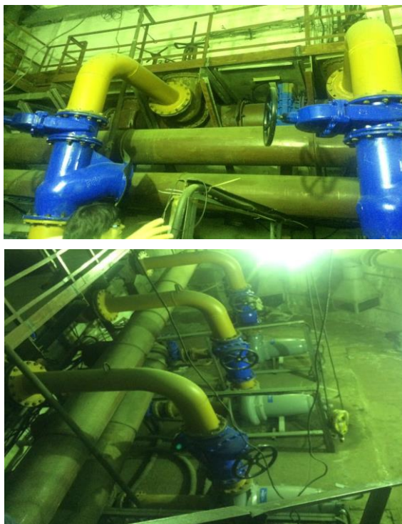
Рис. 1.8. Канализационная насосная станция
