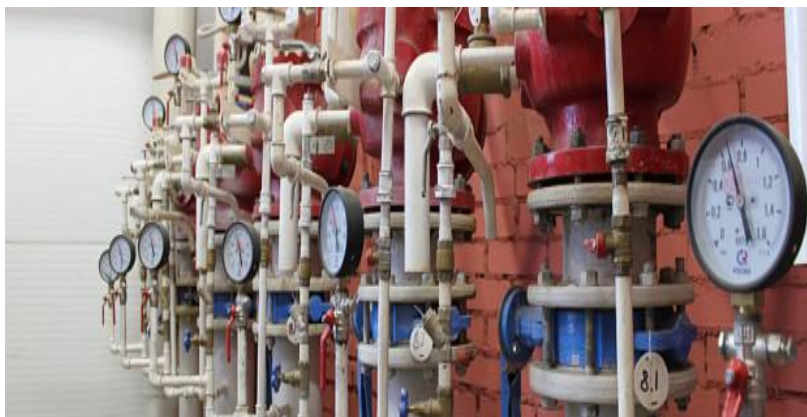
Рис. 1.19. Внутренний противопожарный водопровод
