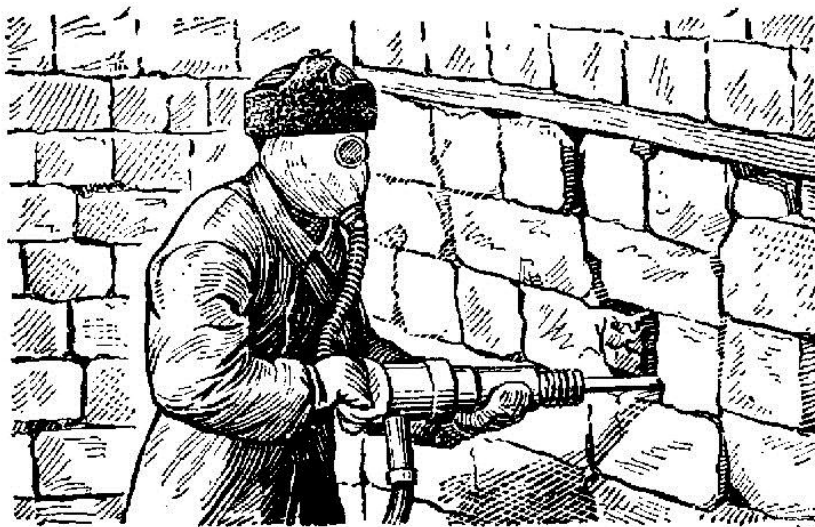
Рис. 4. Пробивание отверстия в стене убежища для подачи очищенного воздуха от вредных веществ
