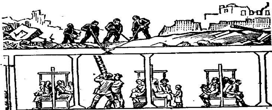
Рис. 6. Пробивание отверстия в перекрытии убежища
