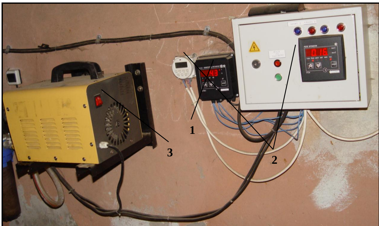
Рис. 54. Туманообразующая установка: теплица для укоренения зеленых черенков (сверху) и система из измерителя-регулятора (1), таймеров (2) и насоса (3)
